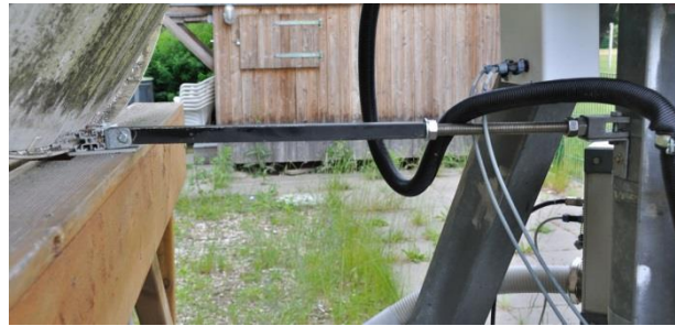
Abb. 20: Elevationsabstützung der Sturmsicherung
