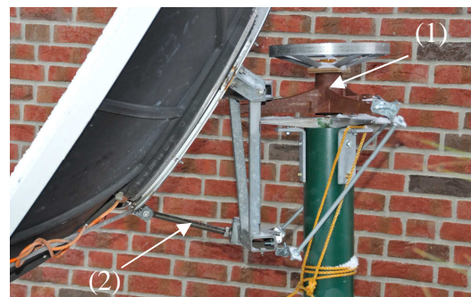
Abb. 5: Befestigung des 180 cm - Reflektors
